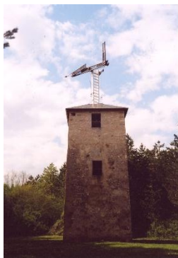
La tour d'Annoux réhabilitée (Yonne)
